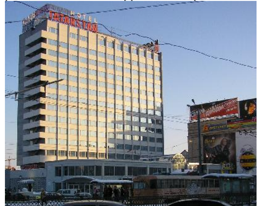
Рис. 5.9 Одно из зданий г. Казани, в оформлении фасада которого использованы детали из алюминия
